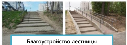
Благоустройство лестницы пр. Бумажников-ул. Маяковского
